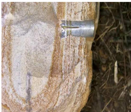
Se deberá prestar atención a los tornillos utilizados para colocar el anclaje en la fijación, estos deberán reunir las características mecánicas de dureza de 8.8.
